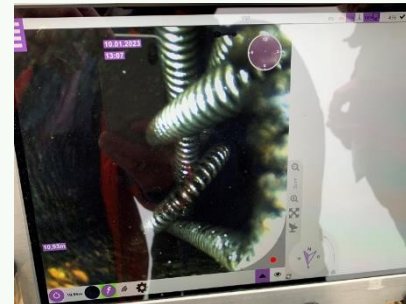
Ontstoppingsveer klemvast in standleiding.
